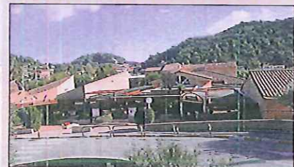
L'architecture actuelle de l'école va être profondément modifiée après les travaux de surélévation s'accompagnant de la création d'une nouvelle cuisine et salle de restauration. (Photo J.O.)
