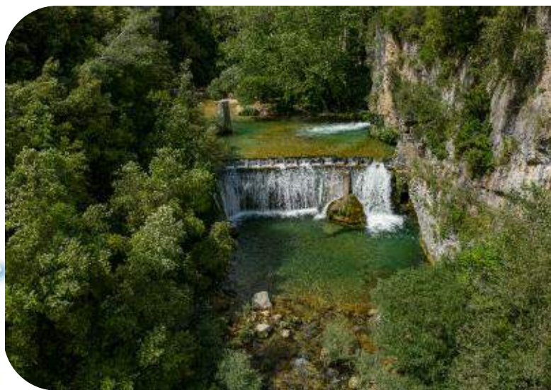
Barrage de Saint-Cézaire-sur-Siagne
