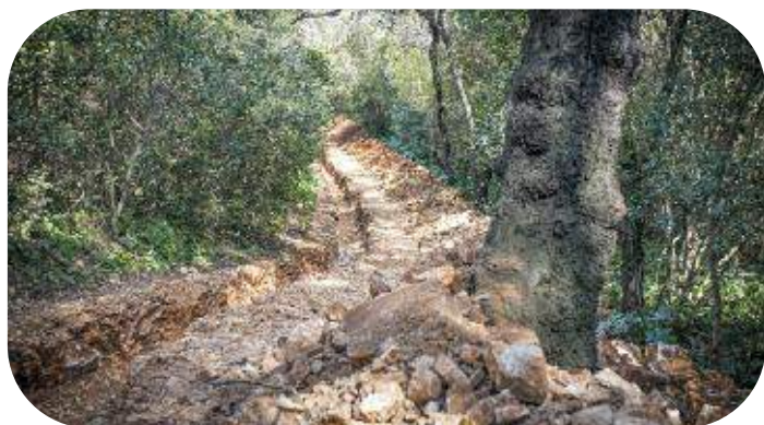
Renouvellement de 1 140 mètres du réseau d'eau potable, Île Sainte-Marguerite à Cannes
