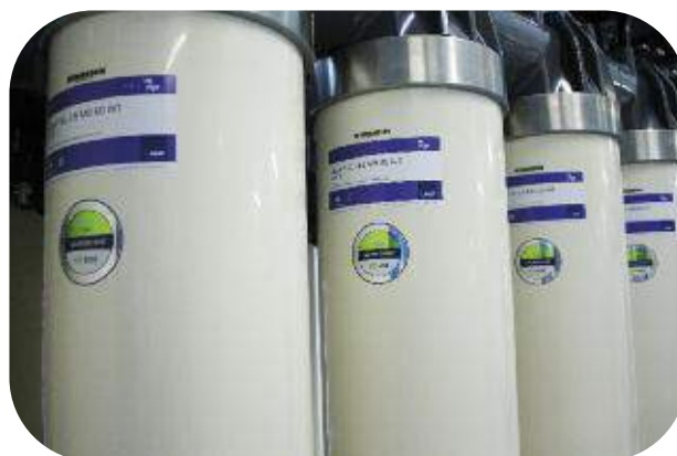
Mars 2017 - changement des membranes d'ultrafiltration
