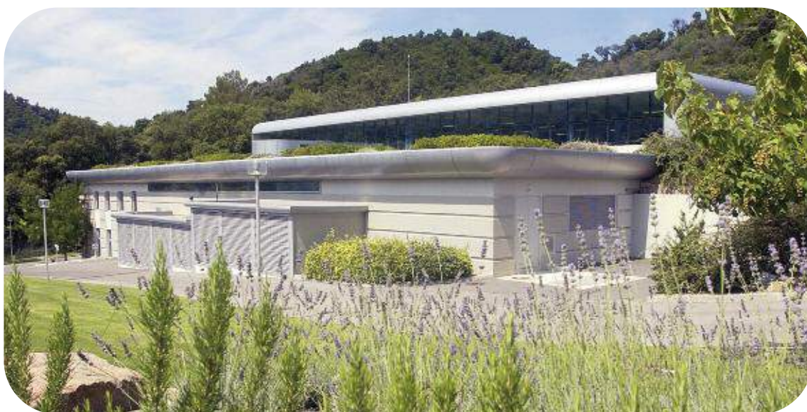
Apié - Usine d'ultrafiltration
