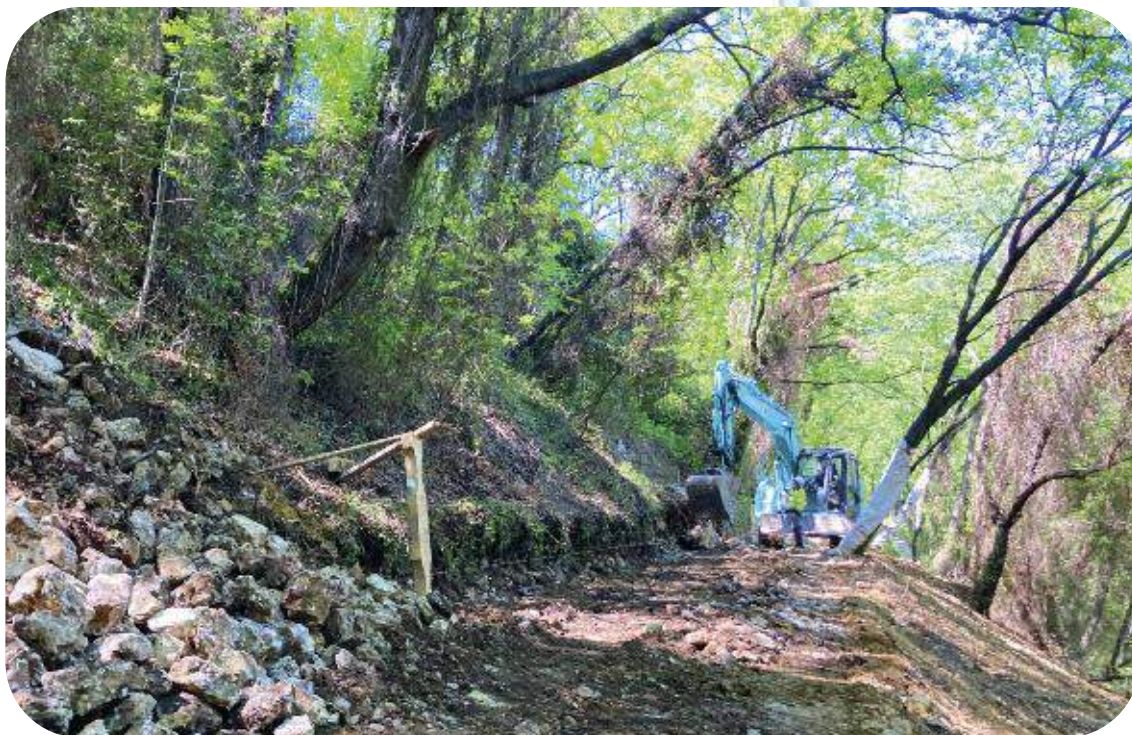
Travaux de renouvellement du canal du Loup
