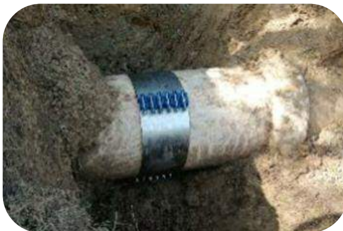
Pose d'un rockwell
