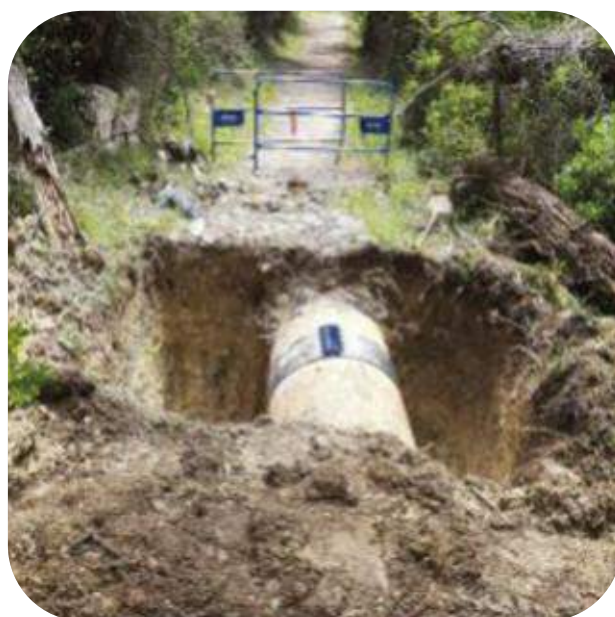
Réparation terminée, chantier sécurisé
