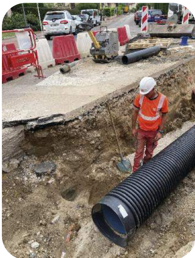
Renouvellement de 320 mètres du réseau d'eau potable, avenue des Mûriers à Cannes
