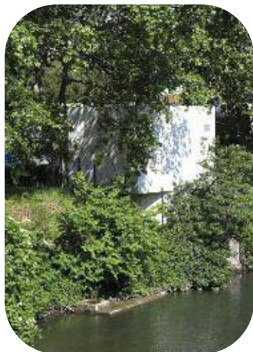
Prise d'eau de la Siagne
