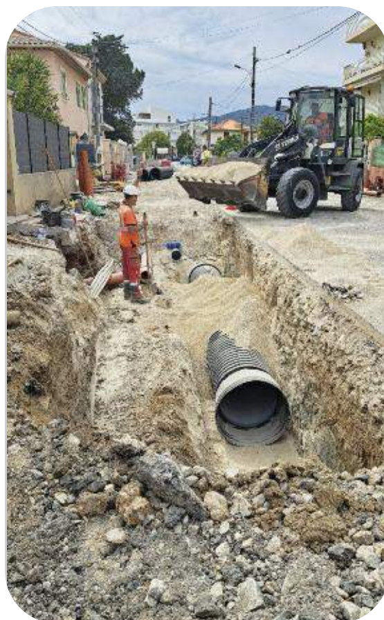
Renouvellement de 320 mètres du réseau d'eau potable, avenue des Mûriers à Cannes
