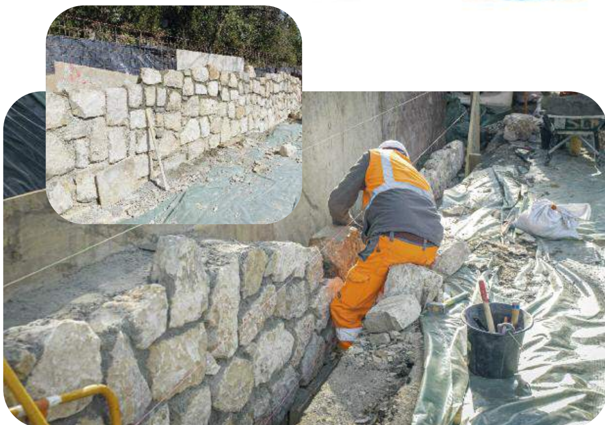
Renouvellement du mur de soutènement du canal de la Siagne, avenue Saint Basile à Mougins
