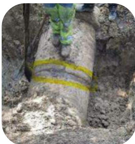
Pose d'un rockwell
