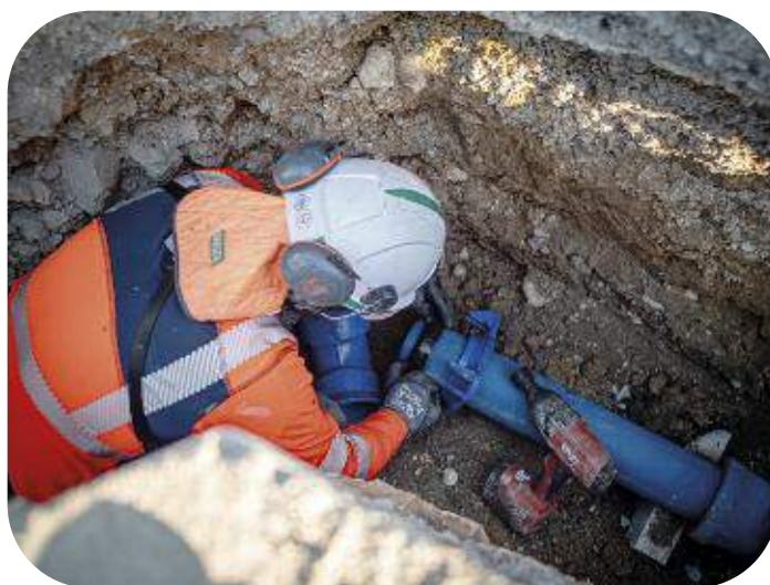
Renouvellement de 350 mètres du réseau d'eau potable, allée des Gabbians à Cannes
