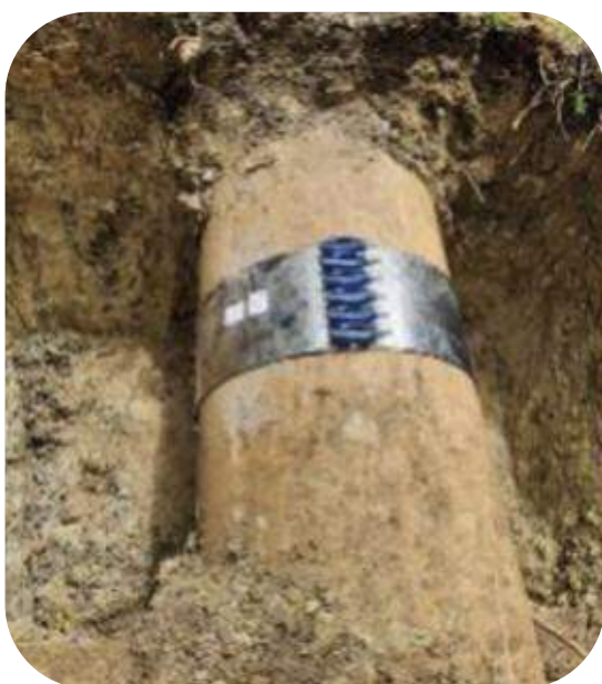
Pose d'un rockwell
