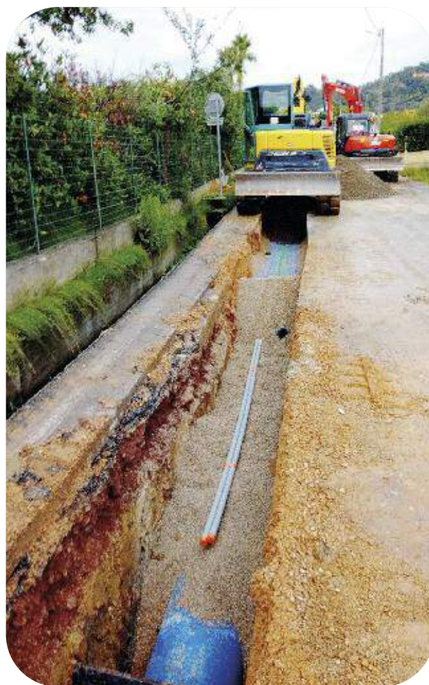
Renouvellement de 500 mètres de feeder DN 500, chemin de la Levade à La Roquette sur Siagne
