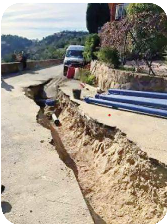
Renouvellement de 700 mètres du réseau d'eau potable, avenue de la Boussole à Théoule-sur-Mer
